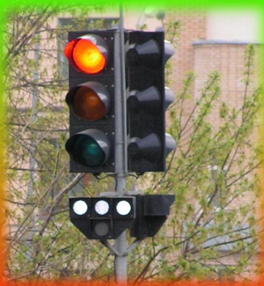
Движение прямо разрешается только при одновременном включении нижнего и верхнего среднего сигналов; поворот направо — только при одновременном включении нижнего и верхнего правого; поворот налево, а также разворот — только при одновременном включении нижнего и верхнего левого. Если включены три верхних сигнала, а нижний выключен, то движение запрещено.
